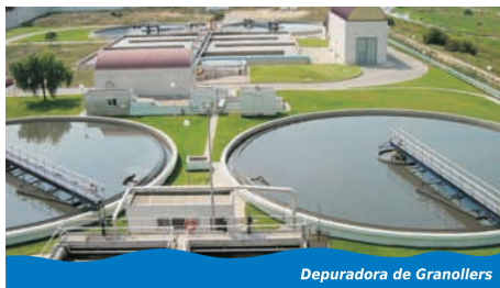
Depuradora de Granollers
